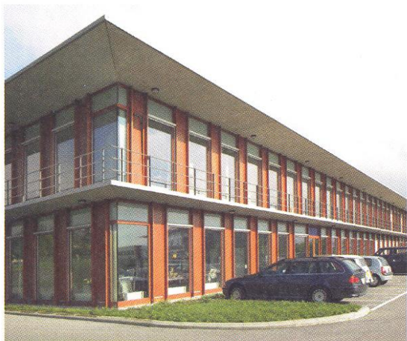
Le bâtiment de Synova SA à Ecublens. (Photos: LDD)
